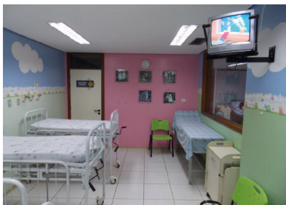
- Instalação de uma televisão na sala de observação infantil no Pronto Socorro / Emergência;
